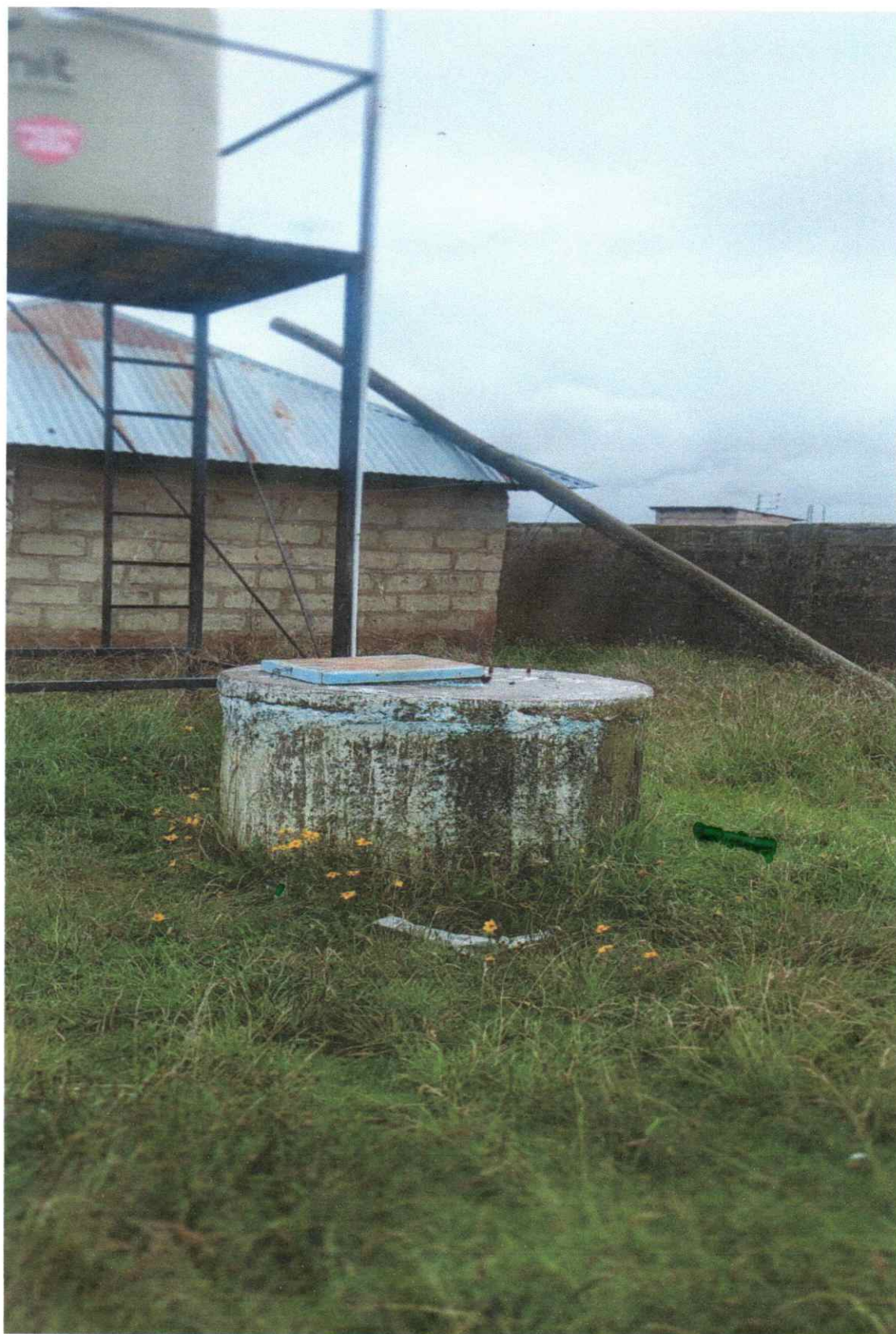
FOTO DEL POSTE CAIDO DE LUZ ELECTRICA DE IEP N° 70378 CALLACHOCO DE PILCUYO
