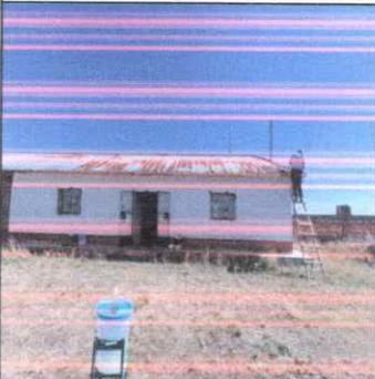
techo de la calamina en estado de oxidación y con algunos goteras en tiempo de lluvia y en tiempo de ventarrones con sonido de calamina .
