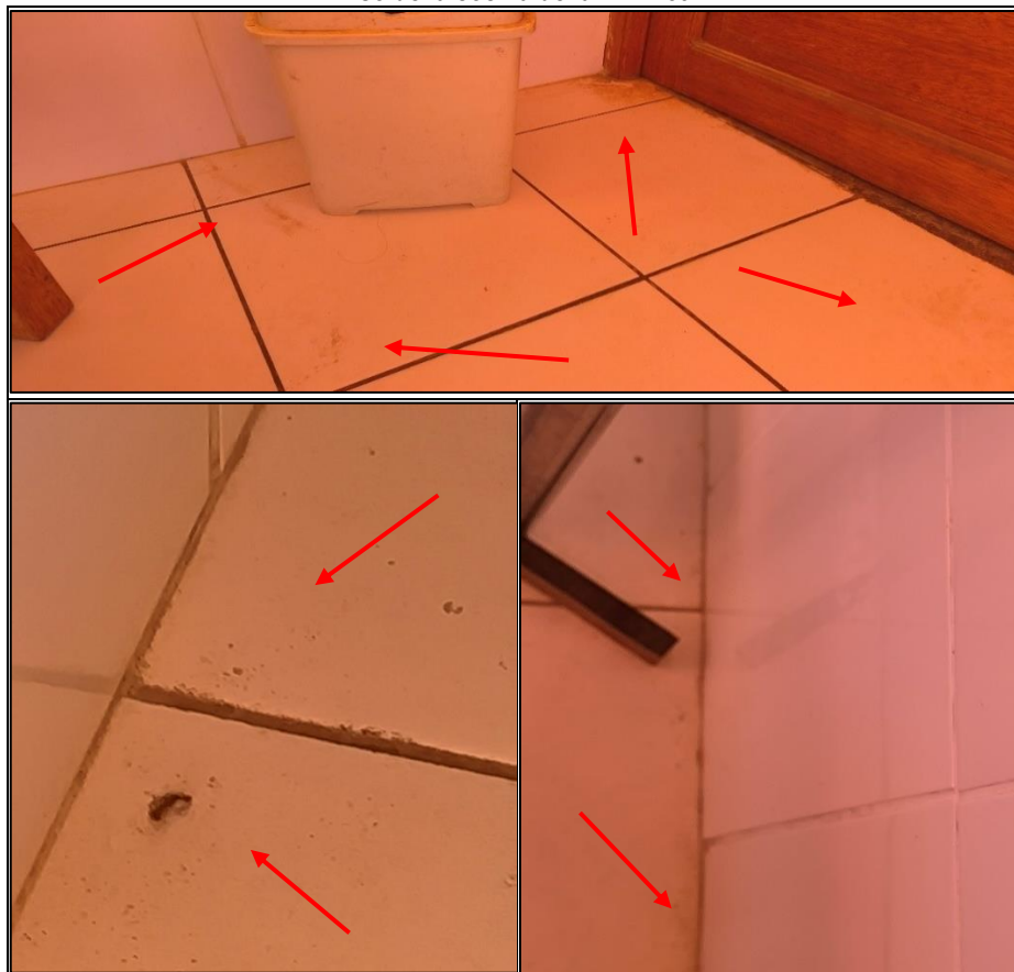
Imagen n.º 4 Piso de la cocina de la IIEE 259
