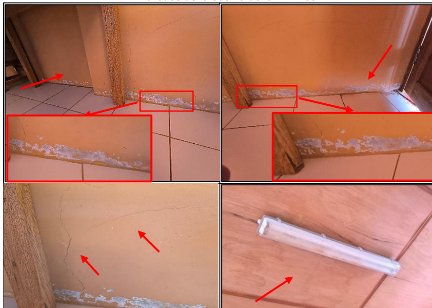
Imagen n.º 1 Paredes de la cocina de la IIEE 259
