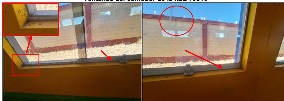
Imagen n.º 18 Ventanas del comedor de la IIEE 70610
