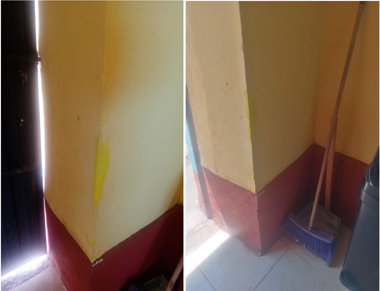
Imagen N°5. Fotografía del área de almacén de alimentos reparada y luego pintado
