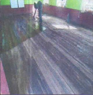
El maestro esta realizando el barzinado para poder culminar el trabajo del piso machihembrado.
