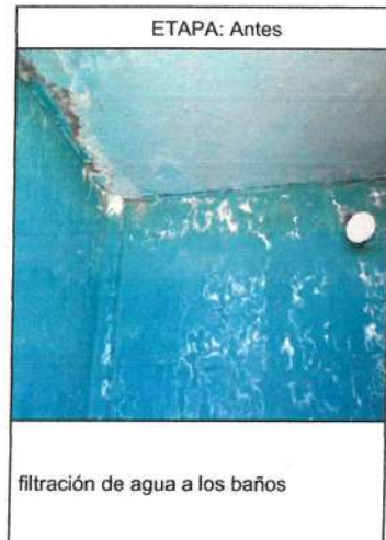
filtración de agua por el techo por falla de tanque
