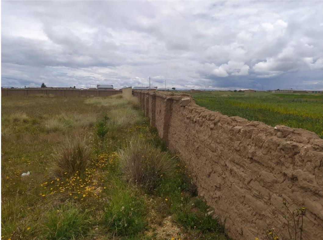
MURO 3 INCLINADO HACIA AFUERA
