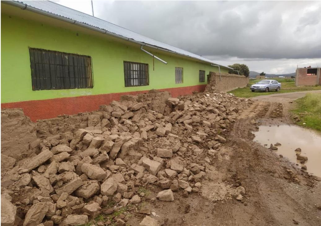
MURO 1 DERRUMBADO HACIA AFUERA
