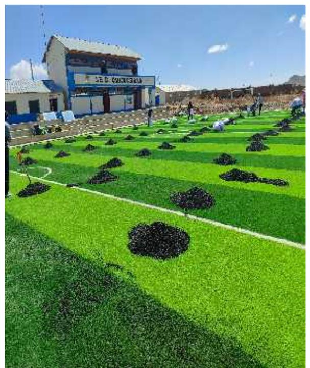
*Ilustración 9 COLOCACIÓN DE CAUCHO GRANULADO*
