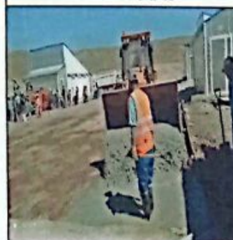
vaceado del piso con la pala mecanica para poder avanzar mas rapido el vaceado
