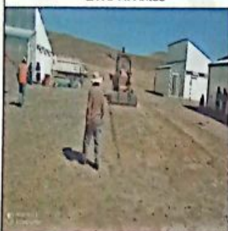
ANTES DEL VACEADO DEL PISO SE HIZO EL RASPADOL CON MAQUINARIA PARA QUE EL PISO ESTE A NIVEL
