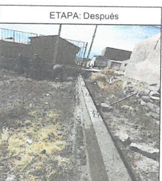
COMO SE OBSERVA EN FOTOGRAFIA SE CULMINÓ CON EL TRABAJO DE CONSTRUCCION DE SARDINELAS DE 560 METROS CUADRADOS PARA LUEGO INSTALAR REJAS DE LIMITE.
