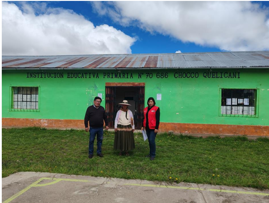
Mantenimiento correctivo de cobertura de calamina
