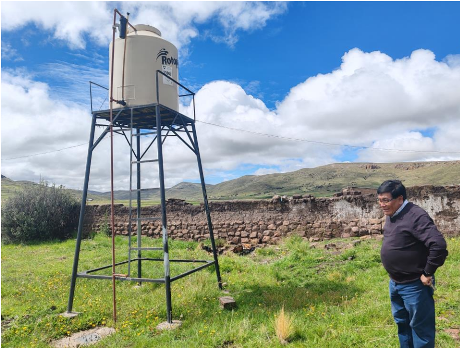
Mantenimiento correctivo de tubería de agua y accesorios
