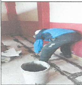
PASA UN TUBO DE DESAGUE Y SE HACE DESVIO CORRECTO
