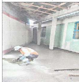
DESPUES EL BASEADO DEL FALSO PISO Y REFINADO DEL PISO
