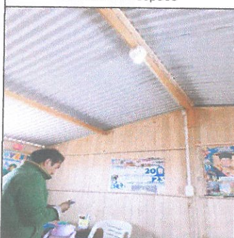
CONCLUYENDO CON LA INSTALACION DE ENERGIA
