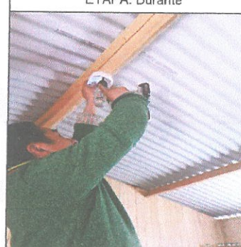
INSTALANDO SOCKET DE LA LUZ DEL AULA
