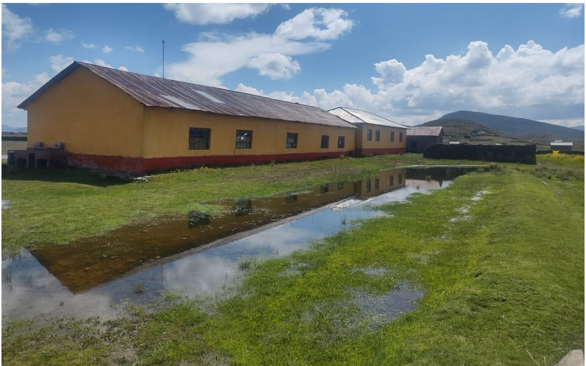
FOTO N°02: PARTE POSTERIOR DE LAS AULAS
