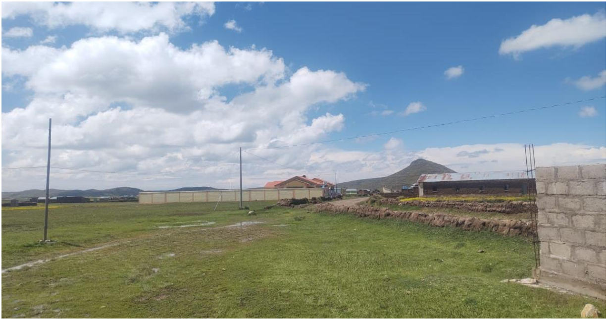
FOTO N°03: MURO DE LA IES
