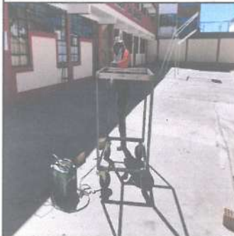
Reparando el tacho deteriorado
