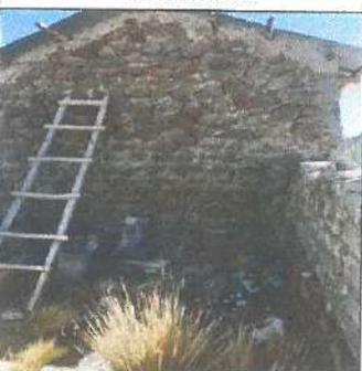
El muro de la cocina sufre filtración de agua de la IEP. 70386.
