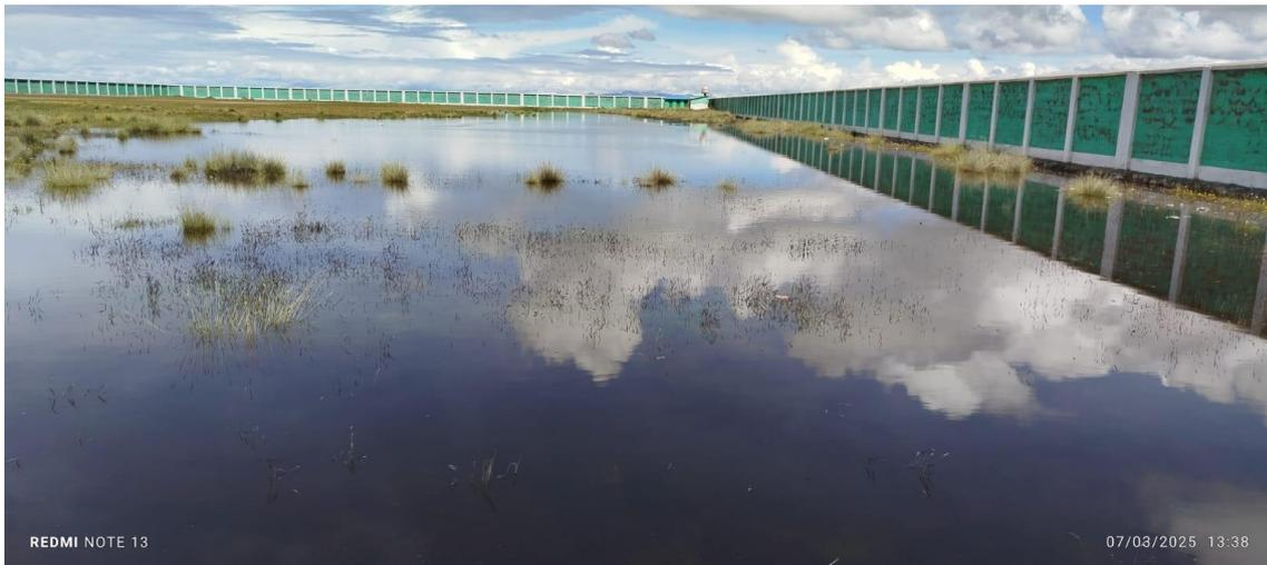
**Figura 3:** Acumulación de aguas pluviales en el acceso principal.
