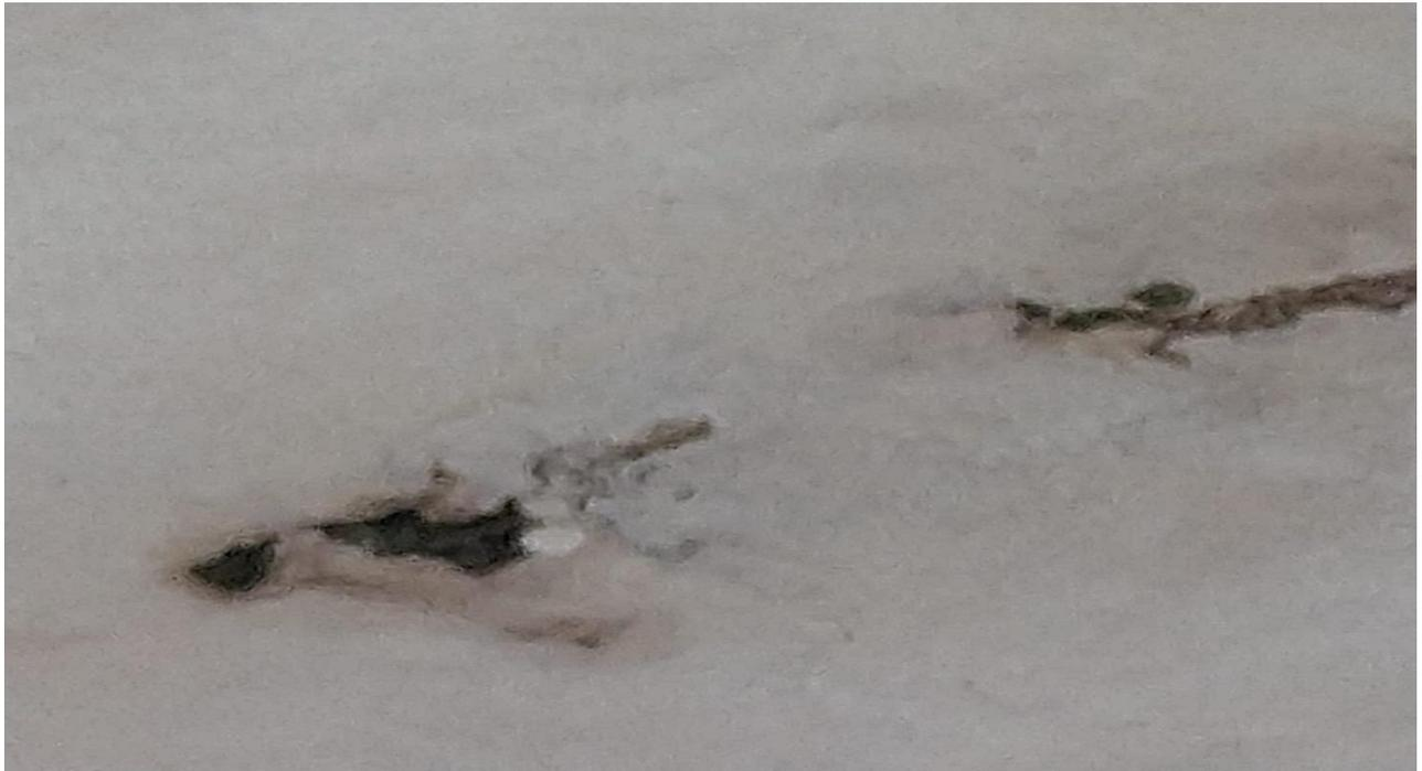
FILTRACION DE AGUA DE LLUVIA POR EL TECHO DE CALAMINA EN EL AULA DE 6TO GRADO
