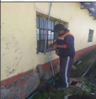
La instalación de la cuchilla termomagnetica para regular el servicio eléctrico al tanque elevado de Rotoplas
