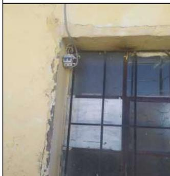
La cuchilla electromagnética ha sido instalada correctamente para que controle el suministro al tanque elevado.
