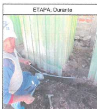
cambio de tubos
