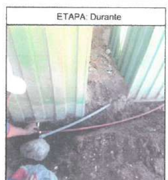
cambio de tubos
