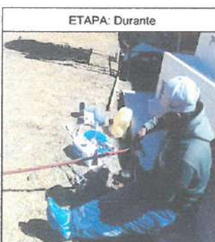
cambio de tubos
