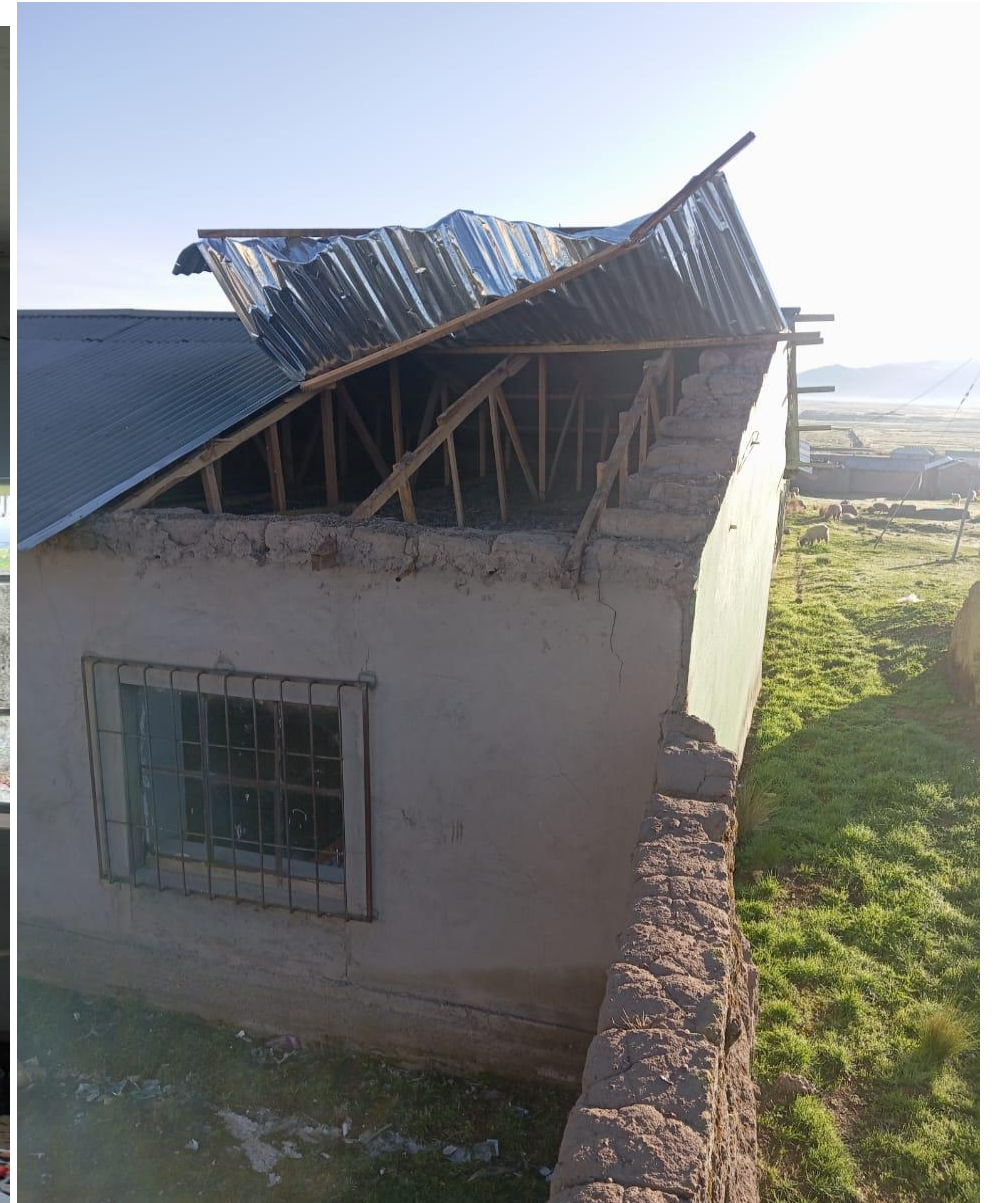
5. Techo del aula de 3 años
