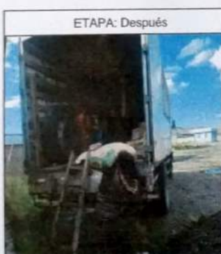
EVIDENCIA DEL MATERIAL DE CONSTRUCCION DESCARGANDO EN LA IE DEL CENTRO POBLADO DE PROVIDENCIA
