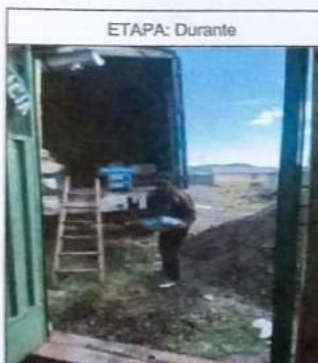
EVIDENCIA DEL TRANSPORTE DESCARGANDO EL MATERIAL DE CONSTRUCCION EN LA IE
