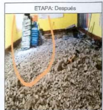
EVIDENCIA DEL MATERIAL DE CONSTRUCCION PUESTO EN EL AULA DE DIRECCION
