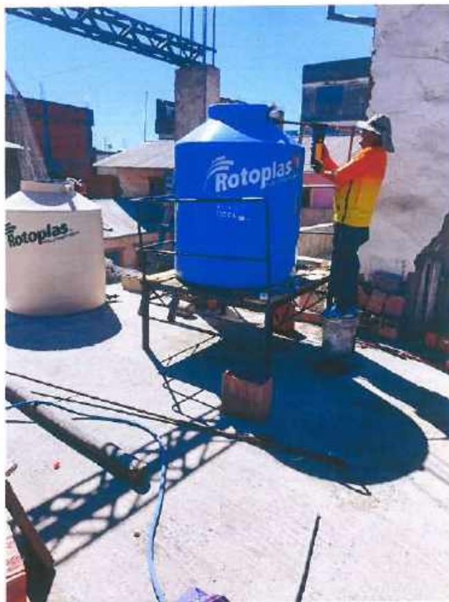
Instalación tanque Rotoplas nuevo y funcionando.
