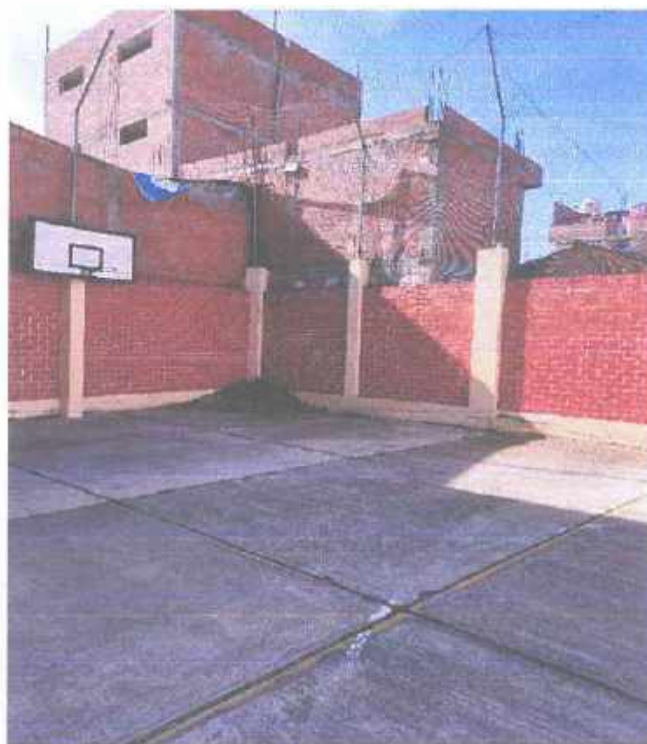
Patio del CEBA sin reflectores
