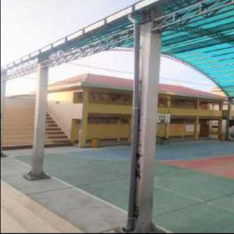
Acabado de colocar tubos pvc en parante metálico con abrazaderas y codos para desfogue de agua.
