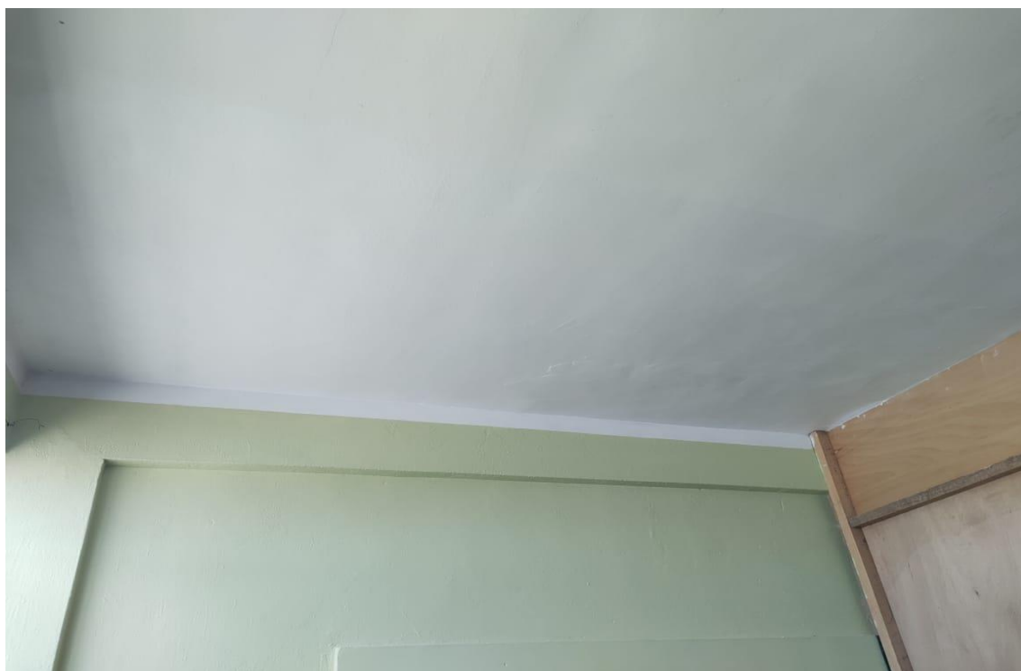
IMAGEN 03: Trabajo acabado de lijado y pintado de cielo raso.
