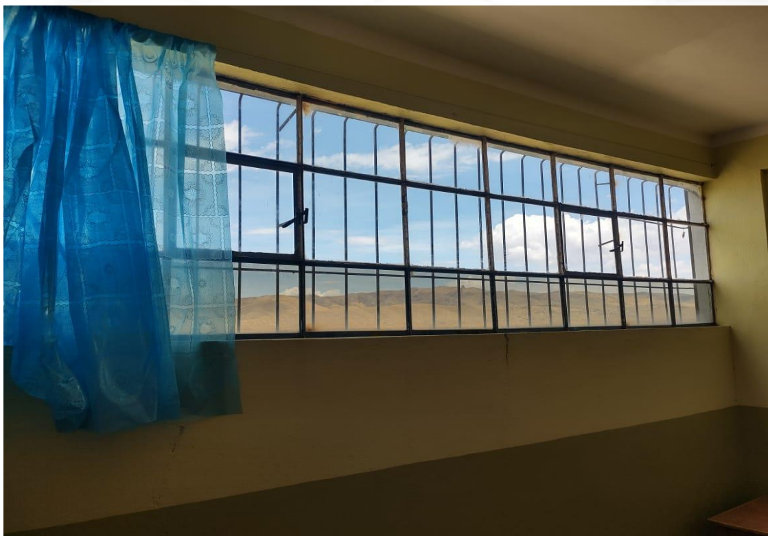
IMAGEN 02: Limpieza de ventana del ambiente acondicionado como almacén.
