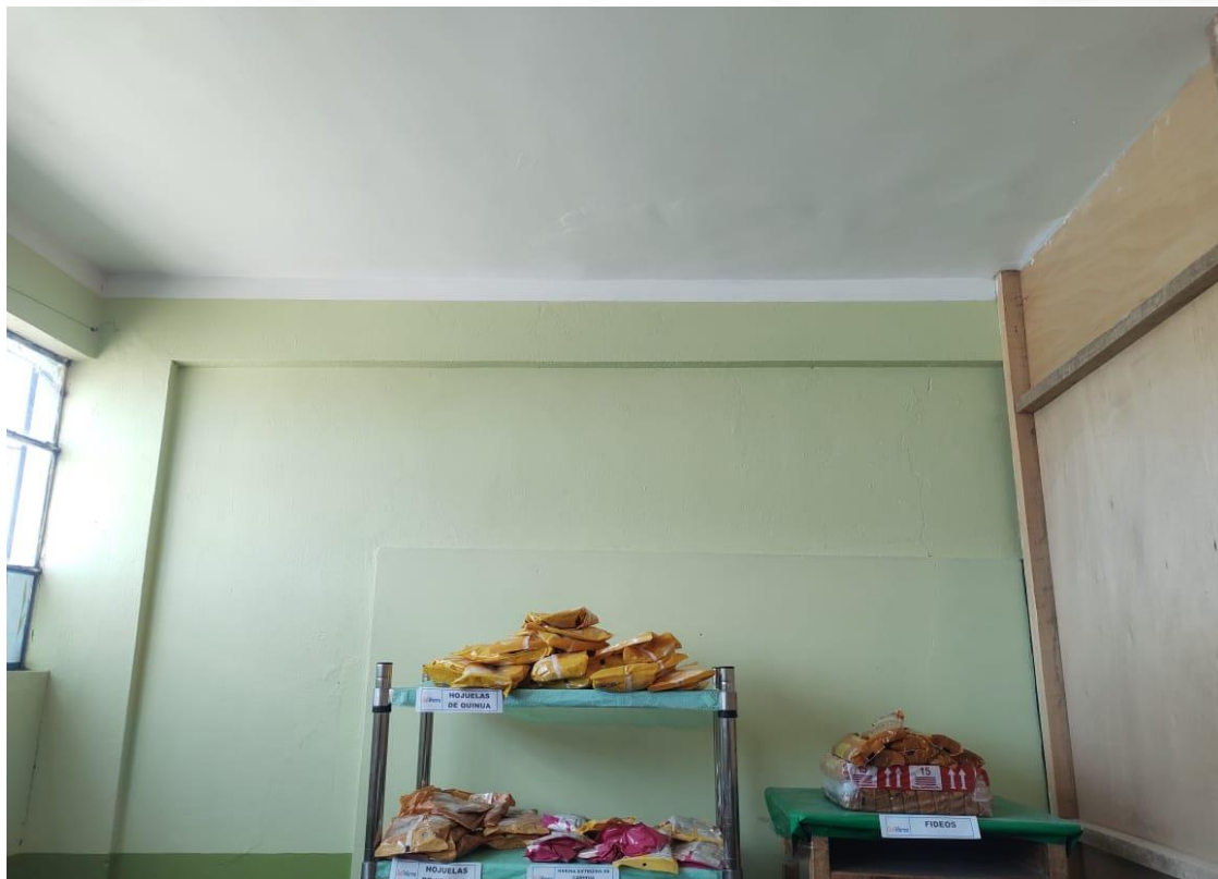
IMAGEN 04: Mesas y estante colocados después de realizado los trabajos de limpieza y pintado de cielo raso.
